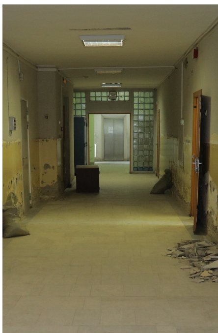
В городской поликлинике начался ремонт первого этажа
